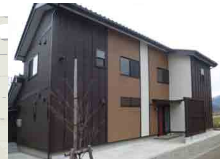
マリンタウンに建つ2号店「アグラディート」。(写真は建築中のもの。)
