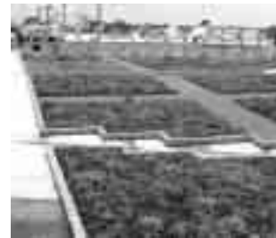
【施工事例：成田空港第2ターミナル】
