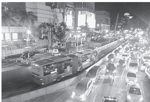
ジャカルタ市内では交通渋滞緩和のために地下鉄工事が始まっている。
