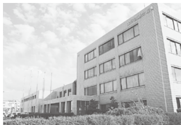
金沢流通会館 外観
