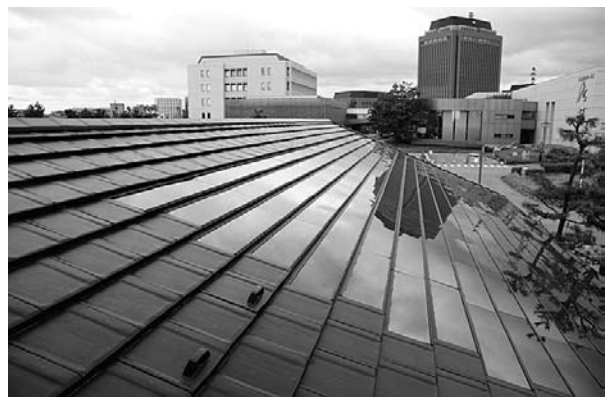
屋根（太陽光発電パネルと小松瓦）
