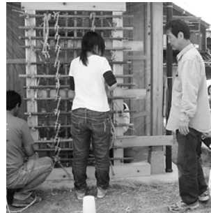
03 縄を縦横に編み竹小舞を掻きます
