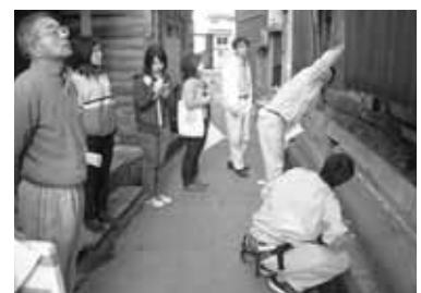
土蔵修復のための調査
