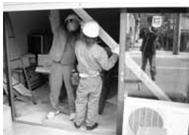
危険な建物への仮筋交い設置
