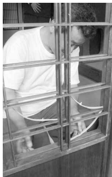
弓竹による歪み補正を職人が指導 障子貼りワークショップ
