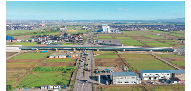
金沢外環状道路 大浦高架橋（完成）
