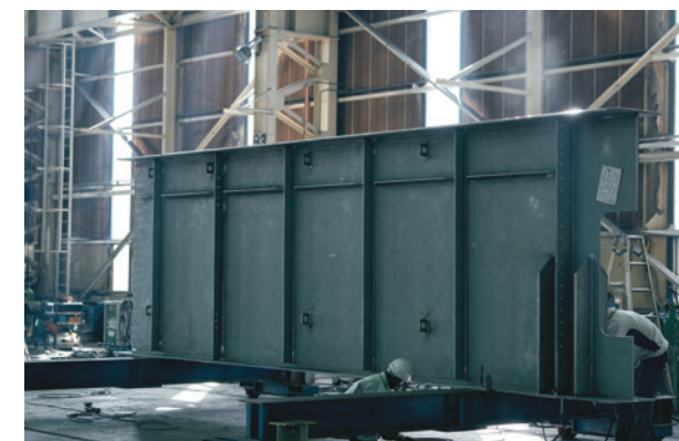
工場で製作中の橋桁
